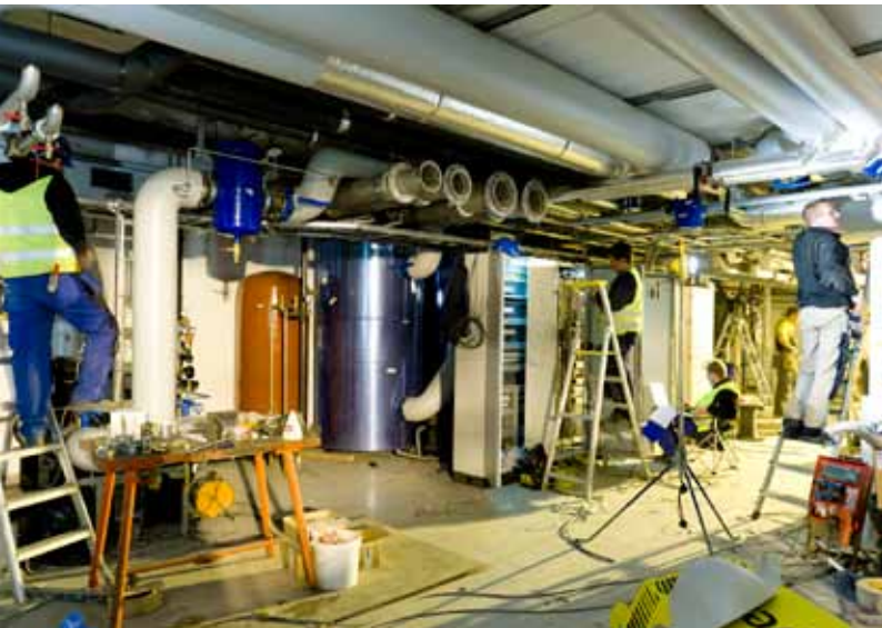
Vulkan energisentral under bygging.
